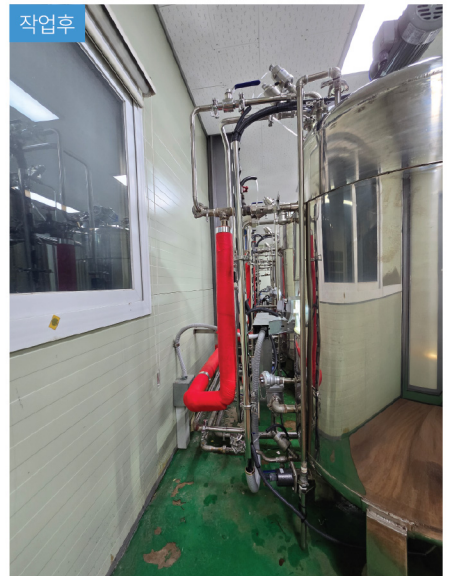
배관 및 배선 오버홀 완료
