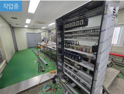
패널 철거 후 자동화 컨트롤 패널 교체
