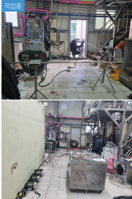
노후 부품 철거 및 저장조 이송라인 철거
