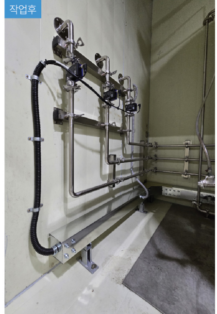
신규 이송라인 설치
