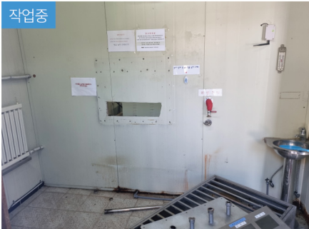
분주 설비 철거
