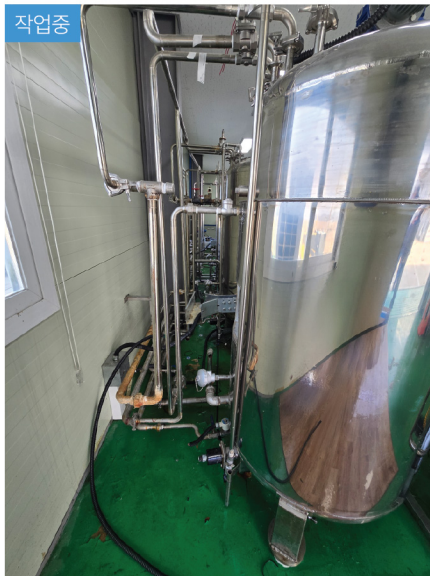
노후 부식 배관 및 배선 철거
