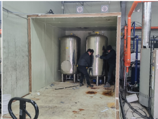
기존 이송라인 및 배관&전장 철거 저장조 및 보일러 이설, 저장조 오버홀 중
