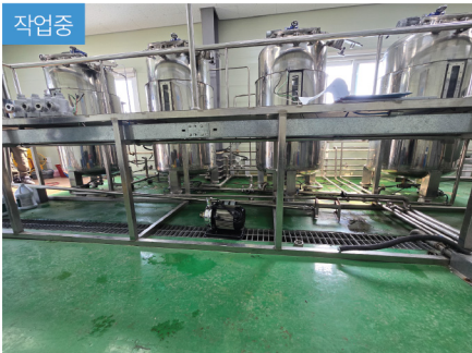
하부 이송라인 철거
